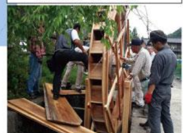
■奈良県吉野町三茶屋 ・直径 3m下掛け水車 ・公共駐車場の外灯
