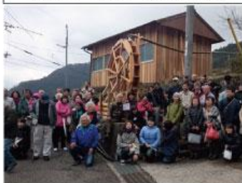
■奈良県十津川村谷瀬 ・直径 3m上掛け水車 ・外灯、動力、防災電源
