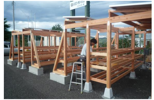
三角棚ソーラーシェアシステム設置工事の様子
